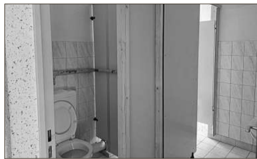
Die Sanitäranlagen wurden mit Kabinen ausgestattet.
