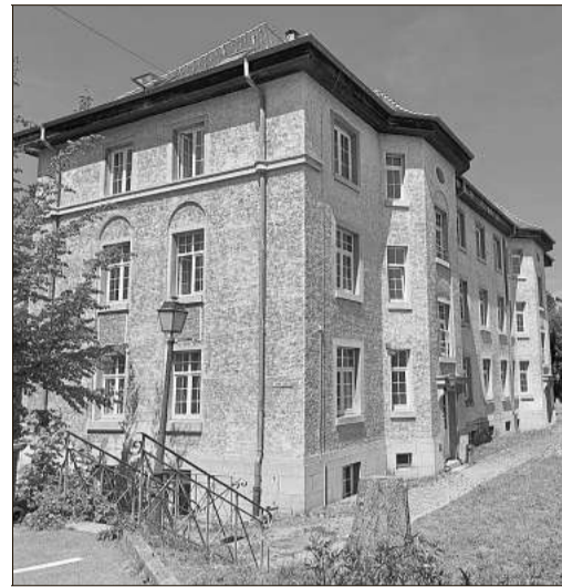
Das Gebäude in der Villinger Straße 48 in Donaueschingen wurde von der Stadt angemietet. Es befindet sich direkt neben dem Konversionsareal.
