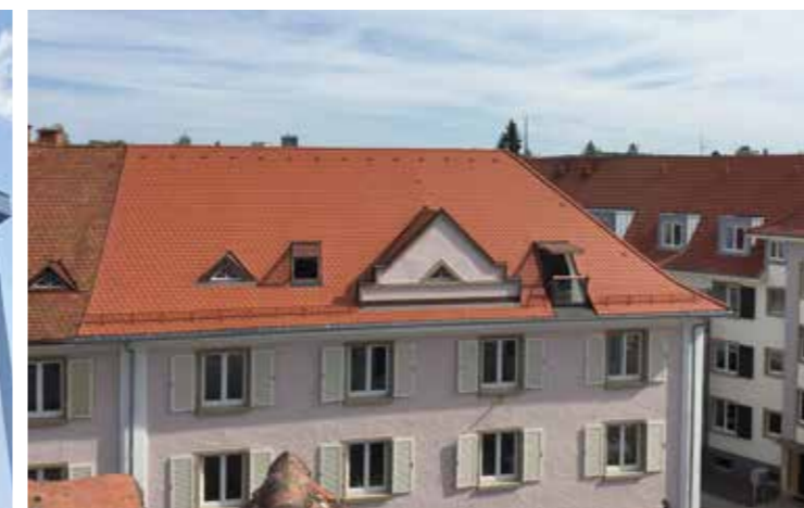
Scheffelstr. 16 Dachausbau und Strangsanierung
