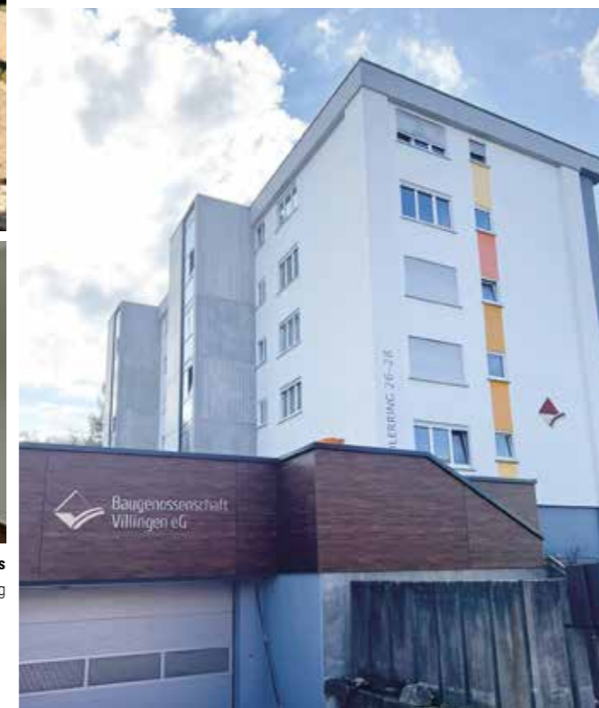
Adlerring 26-28 Aufzugsausbau (an 2 Hauseingängen)
