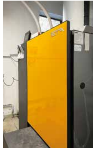
Fasanenstr. 20-26 Grundleitungen Heizung/Frischwasser und Heizzentrale erneuern
