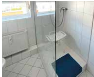
Alemannenstr. 3 | 2. OG links altersgerechter Badumbau
