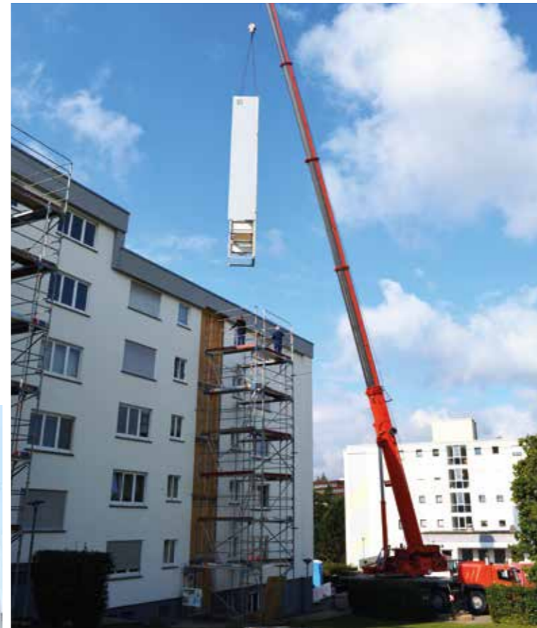
Adlerring 28 1. OG links, 2. OG links, 3. OG links, 4. OG links Maßnahmen: Erneuerung Türen, Wände und Sanitäranlagen sowie Boden- und Balkonbeläge
