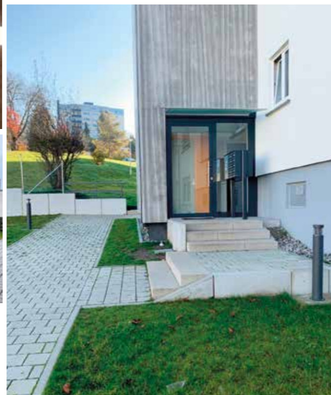
Adlerring 26 - 32 Betonssanierung / Fertigstellung Aussenanlage
