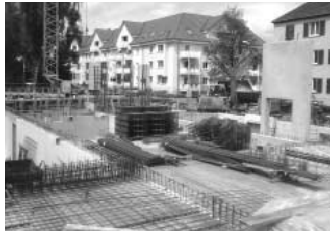
... über die Bauphase ...
