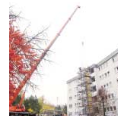
Einbau eines neuen Aufzugs
