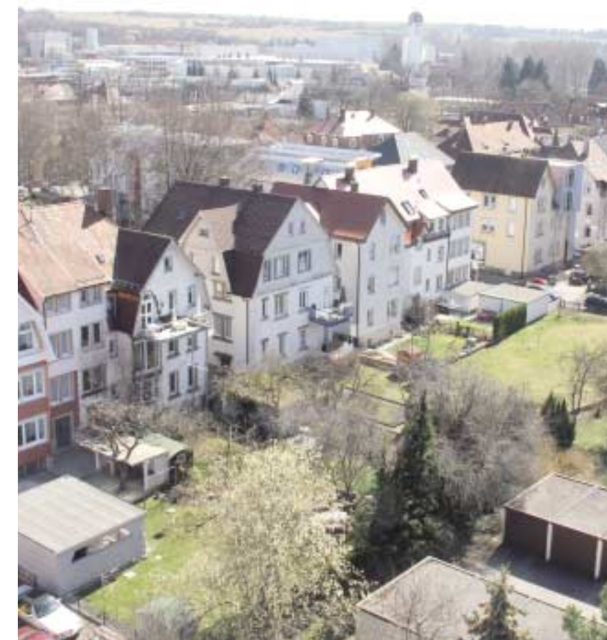
Warenburgareal, Bauabschnitt I
