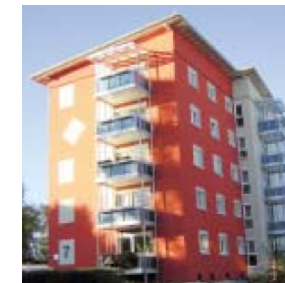
Saniertes Gebäude in der Fasanenstraße
